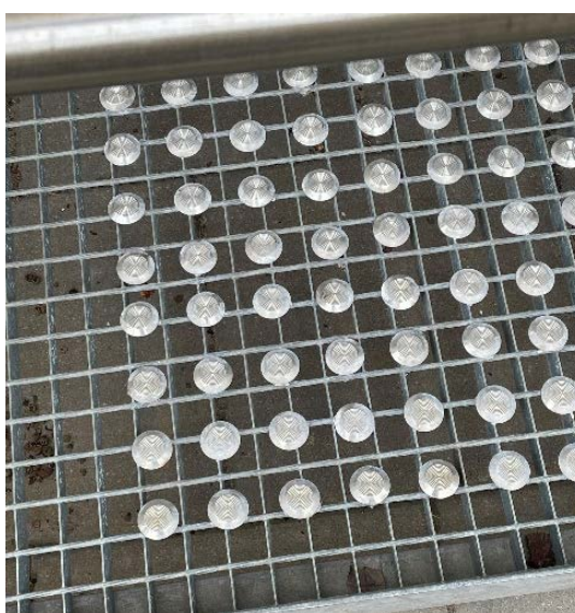
8 pav. Taktilinių paviršių tvirtinimas prie plieninių grotelių
