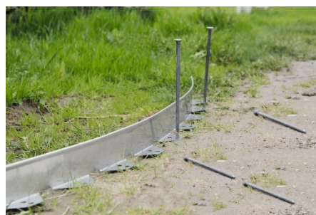
3 pav. Borto montavimo pavyzdys
