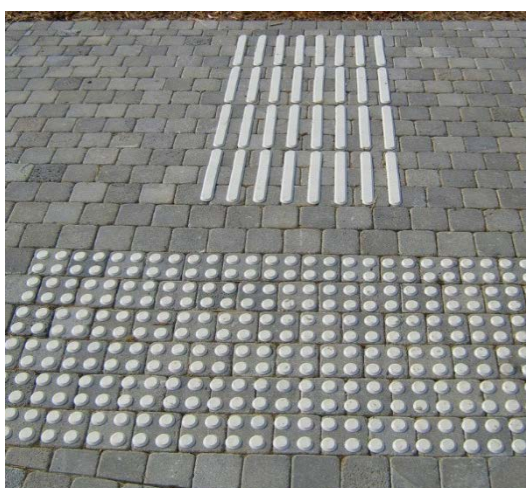
9 pav. Taktilinių paviršių tvirtinimas prie betoninių trinkelų
